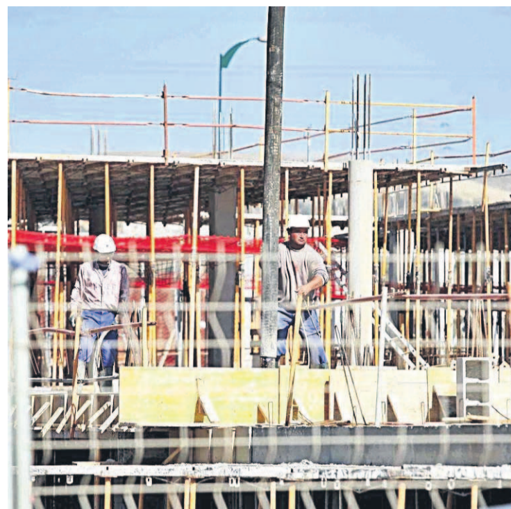
Construcción de una promoción de viviendas en Málaga.
