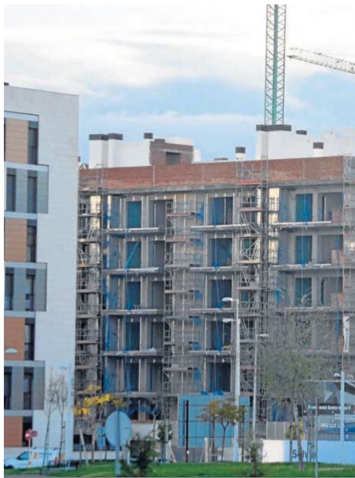
Construcción de viviendas en Córdoba.
