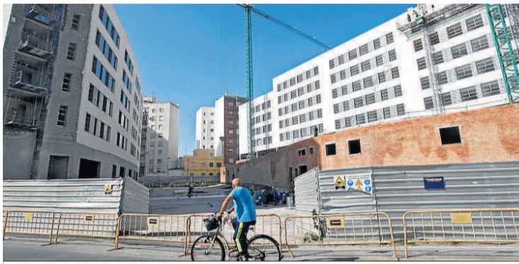
Urbanización de viviendas en construcción.
