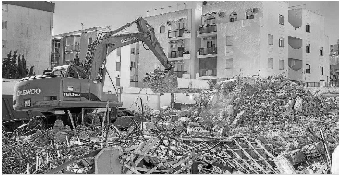
Una excavadora retira los escombros de una parcela para construir una nueva promoción de pisos en Cádiz.
