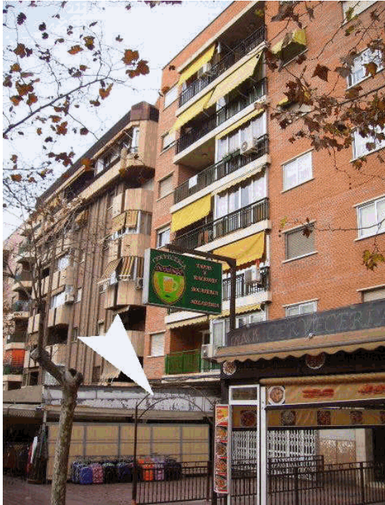
Vista del edificio donde se ubica el inmueble
